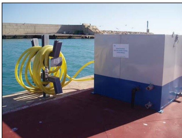
Estació de recollida d'aigües de sentina i aigües residuals
